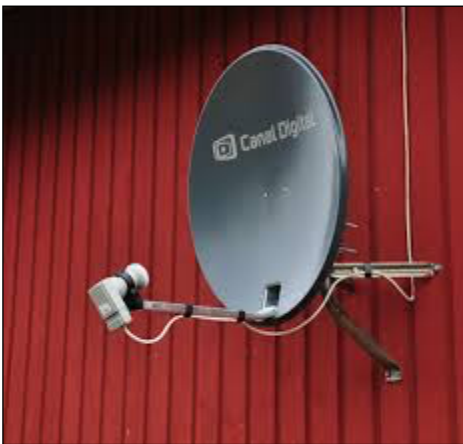
Kuva 9. Esimerkki satelliittiantennin asennuksesta.
