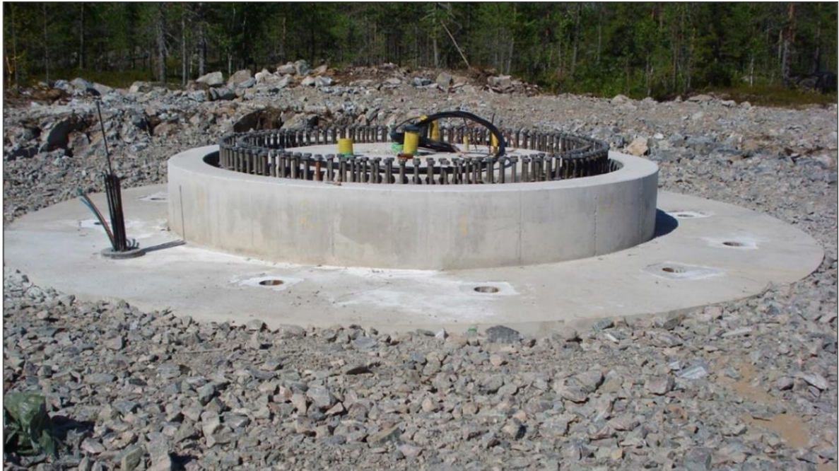
Kuva 6-3. Esimerkkikuva kallioankkuroidusta perustuksesta vierustäyttöjen jälkeen.
