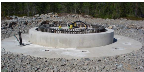
Kuva 6-3. Esimerkkikuva kallioankkuroidusta perustuksesta vierustäyttöjen jälkeen.
