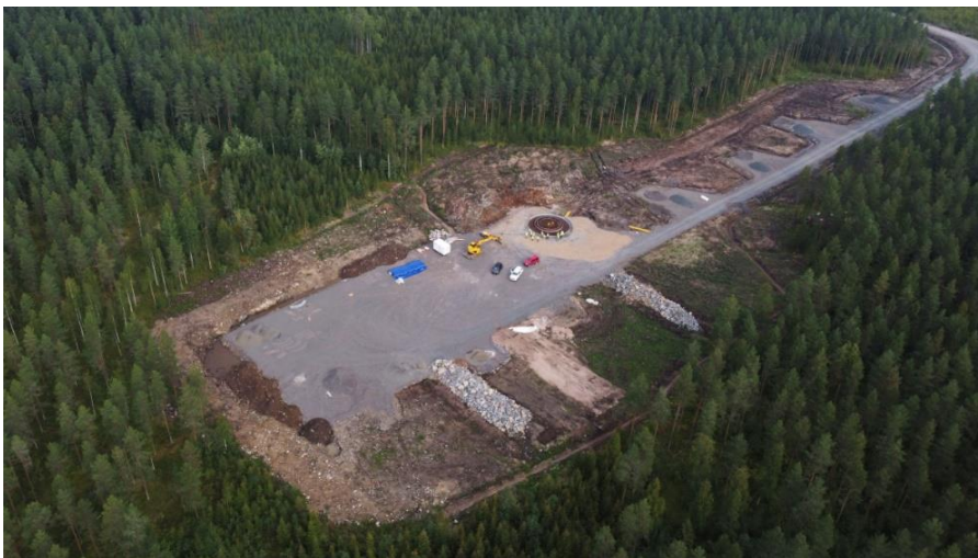
Kuva 6-5. Esimerkkikuva tuulivoimalan kenttä- ja nostoalueesta. (Oka Nuutinen 2024)
