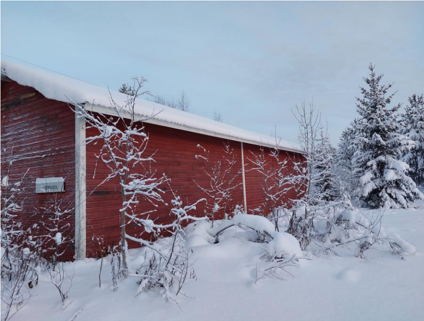
Kuva 3. Entisen kaatopaikan rakennus asemakaava-alueella.
