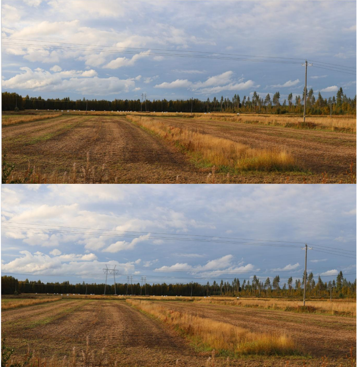
Kuva 9-17. Pyhäjärventien varsi. Yllä YVA-vaiheen nykytilanne. Alla levennetty johtokäytävä, jossa näkyvät molemmat Elenian nykyiset 110 kV voimalinjat sekä Murtomäki 2:n 400 kV voimalinja.
