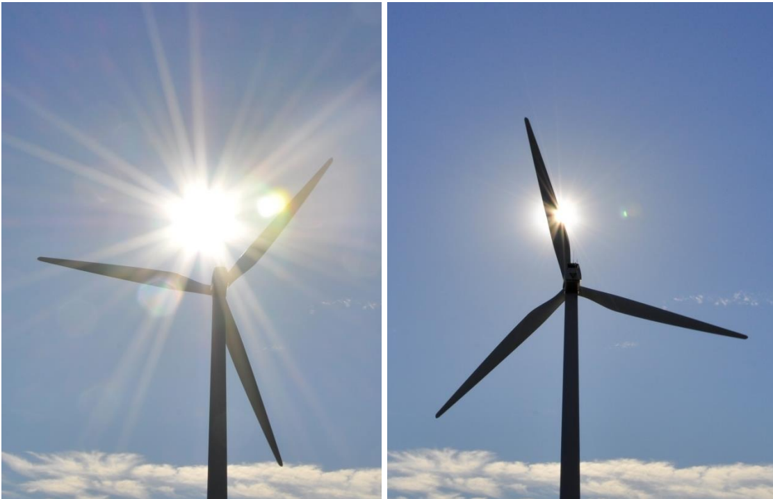
Kuva 18-12. Tuulivoimaloiden lavat aiheuttavat pyöriessään vilkkumista ja varjon välkkymistä aurinkoisella säällä.
