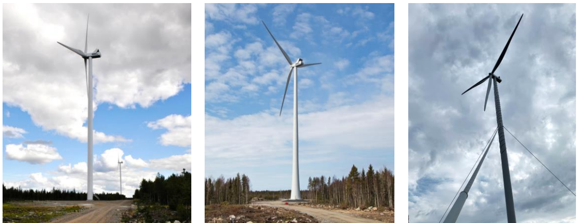
Kuva 4-2. Vasemmalla on esimerkki teräslieriötornista, keskellä hybriditornista ja oikealla harustetusta tornista. 250 metrin korkeuden ylittäminen ei välttämättä tarkoita harustettua tornia. (Kuvat: Leila Väyrynen ja Ville Suorsa, FCG sekä Jarkko Finnilä, Carelin)
