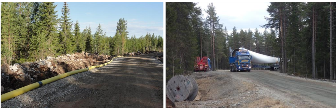
Kuva 4-7. (Vasemmalla) Esimerkki tuulivoimapuiston rakennus- ja huoltotiestä. Teitä käytetään muun muassa betonin, soran ja voimaloiden komponenttien kuljetuksiin sekä tuulivoimapuiston käyttövaiheessa huoltoajoihin. Maakaapeli sijoitetaan ojakaivantoon tien reuna-alueelle. (Oikealla) Tuulivoimalan osia kuljetetaan erikoiskuljetuksina. (Kuvat: Ville Suorsa / FCG).
