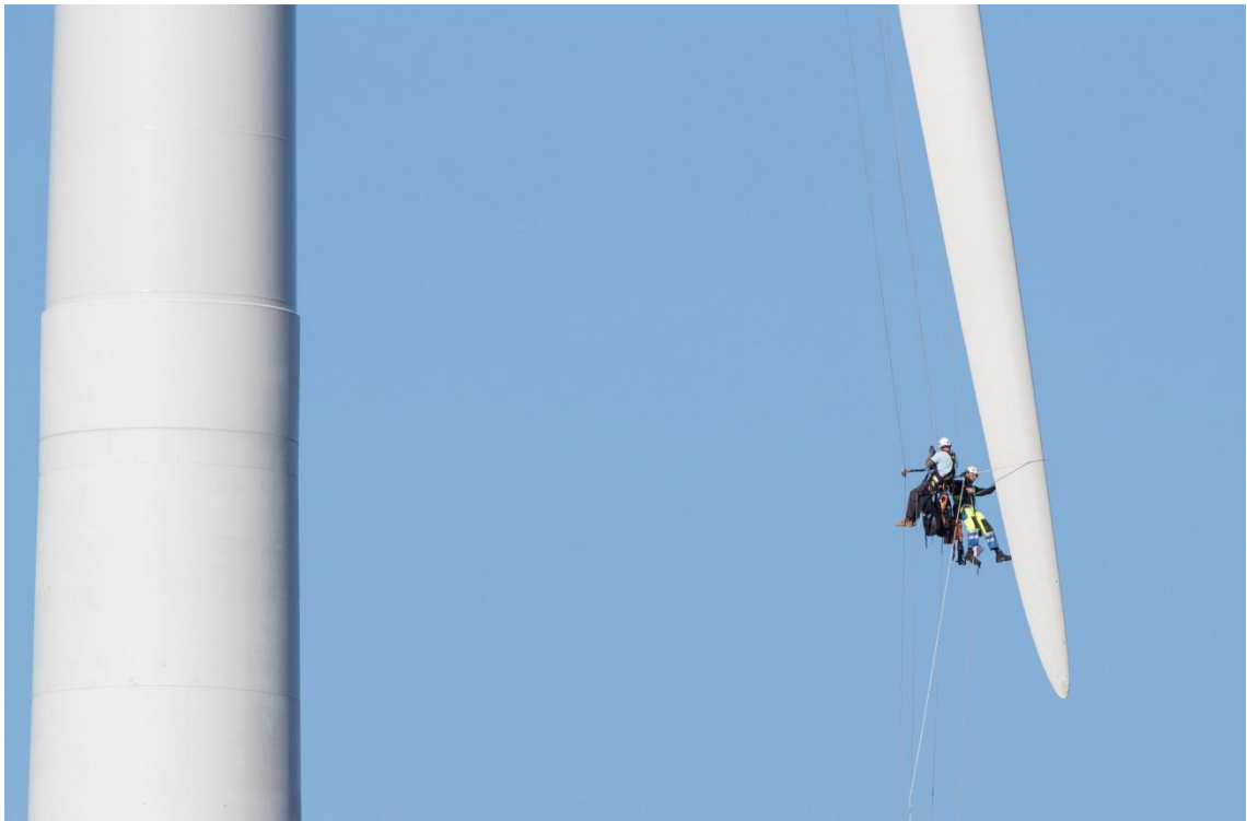
Kuva 4-17. Tuulivoimalan huoltotoimenpiteitä. (Kuva: Ville Suorsa, FCG).
