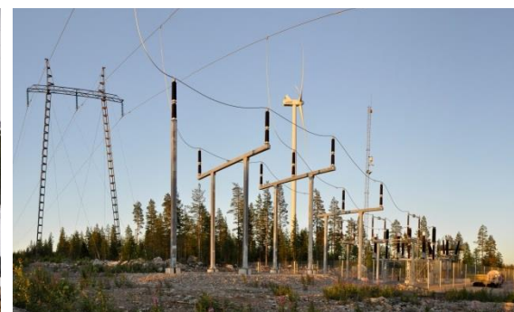
Kuvapari 4-15. Esimerkkikuvia tuulivoimapuiston 110/20 kV sähköasemasta. (Kuva: Leila Väyrynen/FCG).
