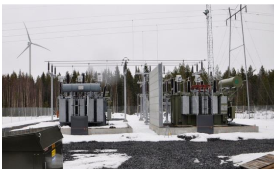
Kuvapari 4-15. Esimerkkikuvia tuulivoimapuiston 110/20 kV sähköasemasta. (Kuva: Leila Väyrynen/FCG).
